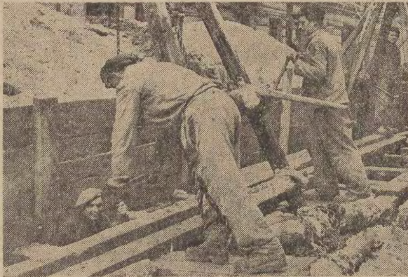
Ogólny fragment robót kanalizacyjnych
