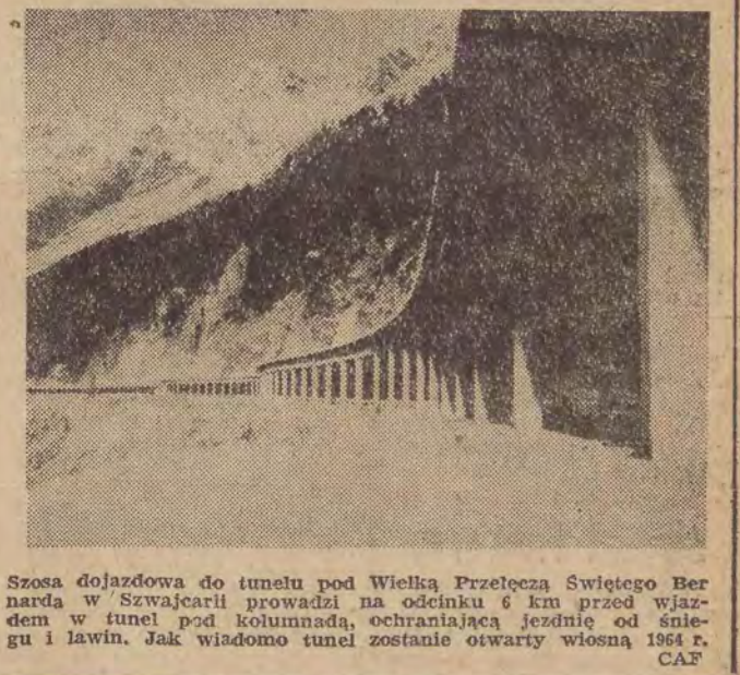
Szosa dojazdowa do tunelu pod Wielką Przełęczą Świętego Bernarda w Szwajcarii prowadzi na odcinku 6 km przed wjazdem w tunel pod kolumnadą, ochraniającą jezdnię od śniegu i lawin. Jak wiadomo tunel zostanie otwarty wiosną 1964 r. (CAF)
