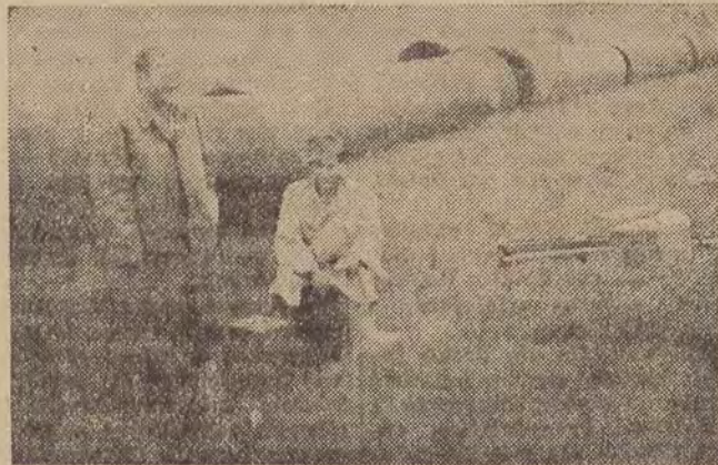
Pomiarowcy: Boberski i Lajer przy pracy nad wytyczaniem drogi rurociągu
