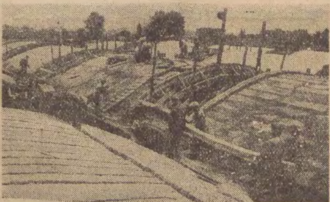
Brygada Kubyszka dzięki kolektywnym metodom pracy wysoko przekracza normy produkcyjne. Na zdjęciu — członkowie tej brygady przy pracy na dachu budowy.
