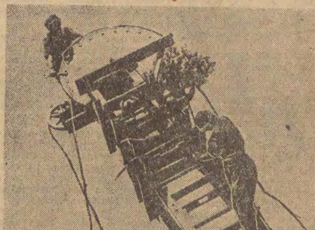
W Goczałkowicach Śląskich przystąpiono do budowy zapory wodnej na rzece Wiśle. Na zdjęciu: Członkowie brygady kafarowej przodownika pracy Henryka Kłosewicza, pracują przy montażu kafara o wadze 3,5 tony. Brygada wyrabia przeciętnie 180% normy.
