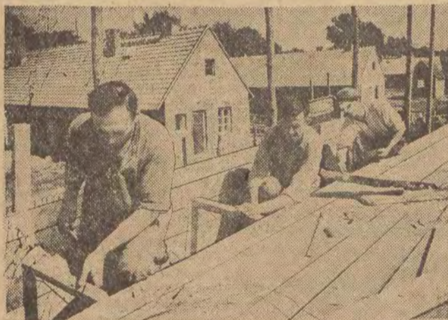
Pracująca brygada cieśli przy zakładaniu oszalowania pod strop przedszkola przy ul. Ziółkowej. Na zdjęciu: Józef Woźniak, Mikołaj Kanlewski i Józef Banczerz.
