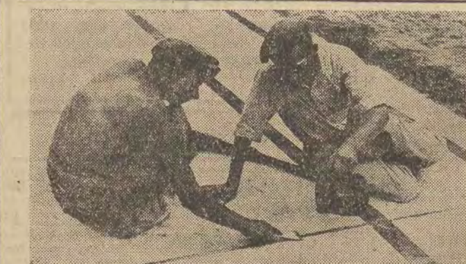
Tor kolarski na Helenowie został już odremontowany. Kazimierz Kulasa wylewa specjalnym lakiem linie mefy.
