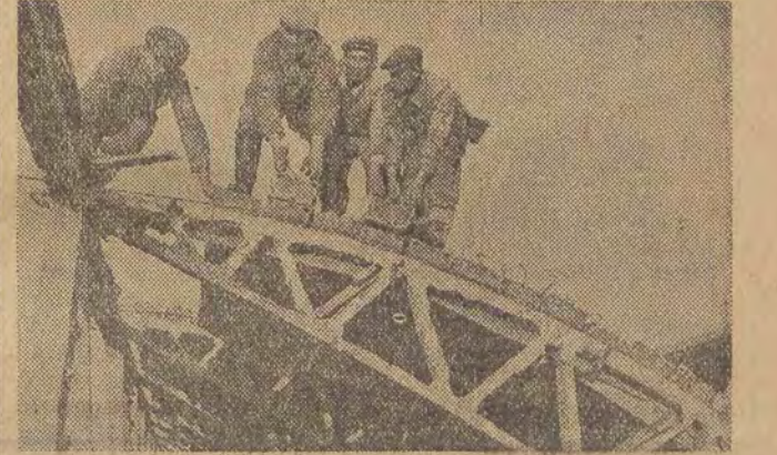
Na wysokich stropach pracują robotnicy, budujący farbarnię w Sieradzu. Do tych robotników w popołudniu ubiegłej soboty zajęła ekipa „Dziennika Łódzkiego”. To spotkanie obrazuje nasz fotoreportaż na str. 6.
