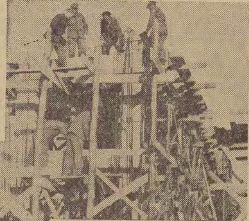
Przodująca brygada ciesielska Alamy stawia rusztowanie ramownicy.
