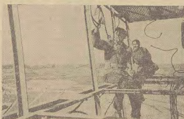
Największy i jeden z najpiękniejszych obiektów sportowych w Polsce — Stadion Śląski w Chorzowie — otrzyma w najbliższej przyszłości sztuczne oświetlenie, które pozwoli na rozgrywanie spotkań wieczorem. Z początkiem maja br. przewidziane jest zakończenie prac przy montażu potężnych reflektorów o sile 5.000 świec każdy. 20 takich reflektorów znajdzie się na 4 masztach o wysokości 30 metrów. Maszty wykonał chorzowski „Konstal” a montaż reflektorów wykonują ekipy katowickiego „Elektromontażu”. Na zdjęciu: pracownicy „Elektromontażu” na szczytach 30-metrowego masztu podłączają kable elektryczne. CAF — fot. Seko
