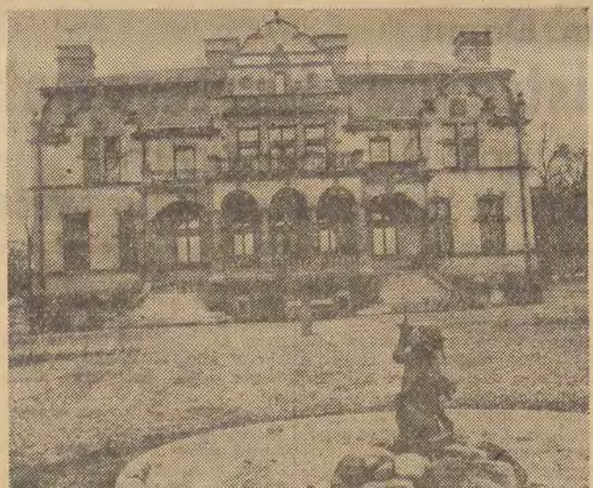
Gdy N. S. Chruszczow odwiedził w sierpniu Szwecję zamieszkała prawdopodobnie w tym oto pałacyku w Blaukeberg zbudowanym w 1893 r. Fot. — CAF
