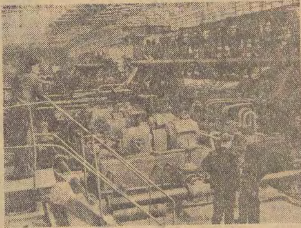
W czelabińskiej walcowni rur produkowanych dla przemysłu natowego ZSRR, zainstalowano trzecią automatyczną linię do spawania rur w łuku elektrycznym. Na zdjęciu: ogólny widok nowego urządzenia. Fot. — CAF
