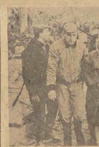
Ponad 500 zabitych, miliardowe straty materialne — to skutki przerwania przez wzburzone wody zapory w Malpasset. Fot. — CAF
