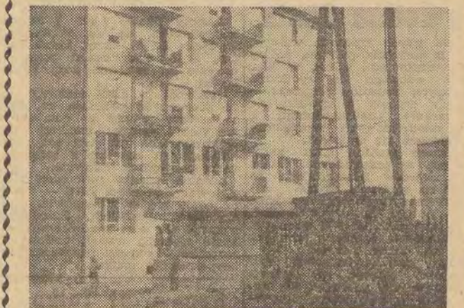
Tuż obok nowego bloku przy ul. M. Fornalskiej 16/18 już przed kilku miesiącami ustawiono kioski. Niestety do dziś jest zamknięty. Ale jeszcze bardziej razią oczy przechodniów szopa i słup oraz okropny plotek ustawione podczas budowy domu. Choć dziś są już zupełnie niepotrzebne — stoją nadal i stanowią bryldną dekorację ładnego fragmentu osiedla. foto: L. Olejniczak
