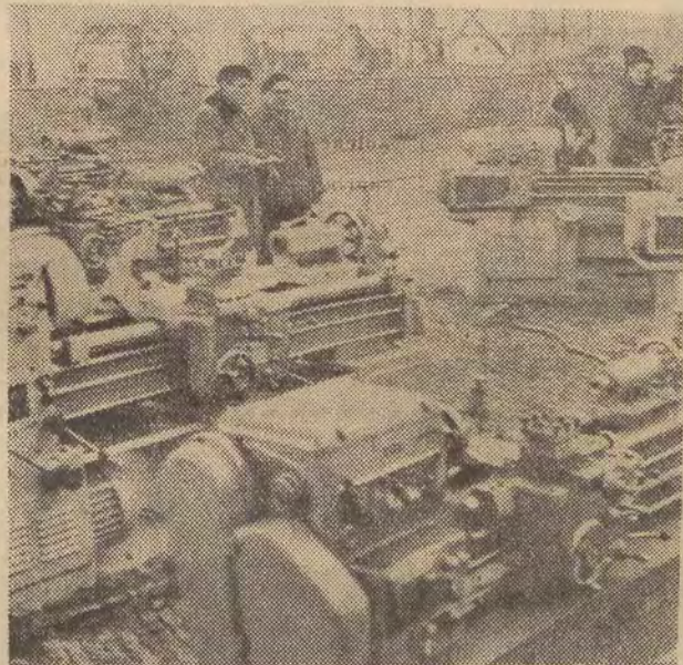
Fabryka Transformatorów i Aparatury Trakcyjnej. Na zdjęciu: hala narzędziowa.
