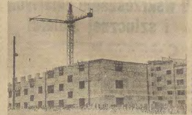
Niedaleko fabryki przy ul. Traktorowej powstaje osiedle mieszkaniowe dla pracowników „Ela”. Do końca tego roku w I bloku zamieszka 36 rodzin. W przyszłym roku zostaną oddane do użytku dwa następne bloki liczące 72 mieszkania. (Kr.)
