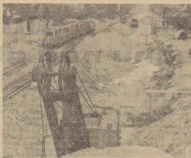
Tramwaj linii nr 45 zwalnia do 2 km/godz. Cały teren obok parku na Julianowie — to prawdziwe wykopaliska. Powstaje tu nowa arteria komunikacyjna.
