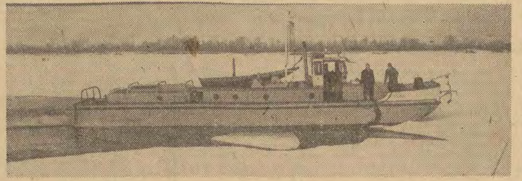
Choć mróz jeszcze ściska i obfite opady śnieżne pokrywają grubą powłoką teren całej Polski, trwają już intensywne prace przygotowawcze do wiosennego spływu lodów. Na zdjęciu: Wisła w okolicach Warkł. Łodolamacz „Dziwina” kruszy lody. CAF - fot. Chmielewski
