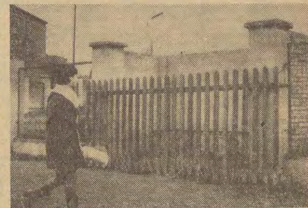
Można się wprawdzie domyślać, że miała to być poczekalnia tramwajowa, ale ponieważ stała całą zimę bez dachu, a podróżni czekający na tramwaj również stali „bez dachu” — rzecz w związku z nadejściem wiosny chwilowo straciła na aktualności.
