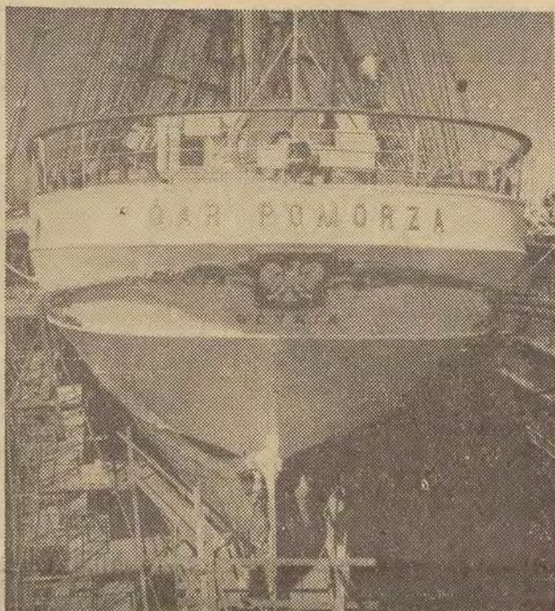
We wrześniu mija 35 lat jak „Dar Pomorza” pływa pod polską banderą. Obecnie statek stoi w doku w Gdańskiej Stoczni Remontowej i przechodzi konserwację kadłuba. Na zdjęciu: w doku. CAF - fot. Uklejewski
