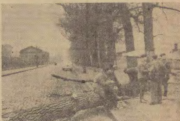
Na ulicy 8 Marca przystąpiono do wycinania, mających ponad 100 lat topoli. Okazuje się, że drzewa te już umarły. Trzeba więc je usunąć z tego choćby względu, aby nie tarowały tu ruchu. Foto: L. Olejniczak
