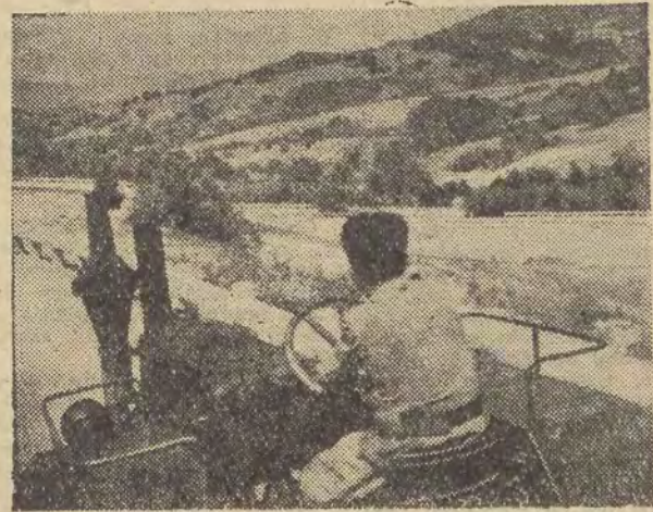
W Bieszczadach prowadzi się prace przy budowie ostatniego odcinka drogi zwanej „obwódnicą” lub „petlą” bieszczadzka. Przy budowie tej drogi, jak też dróg leśnych pracują żołnierze i oficerowie KBW, którzy w 1947 r. walczyli na tych terenach z bandami UPA.
