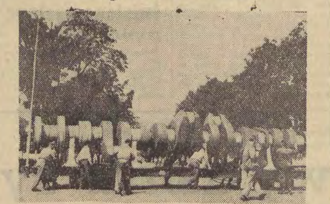
Jeden z eksponatów — wał karbowy produkcji Zakładów Metalurgicznych im. Klementa Gottwalda, waży 55 ton i ma 11 m długości. Przechwycony jest dla polskiego przemysłu okrętowego. CAF
