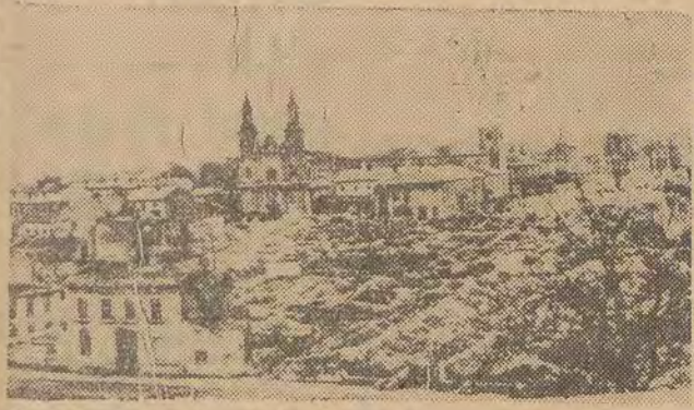
Na skutek nalotu uległo zniszczeniu ok. 60 proc. wszystkich budynków — po wielu ulicach nie zostało śladu...
