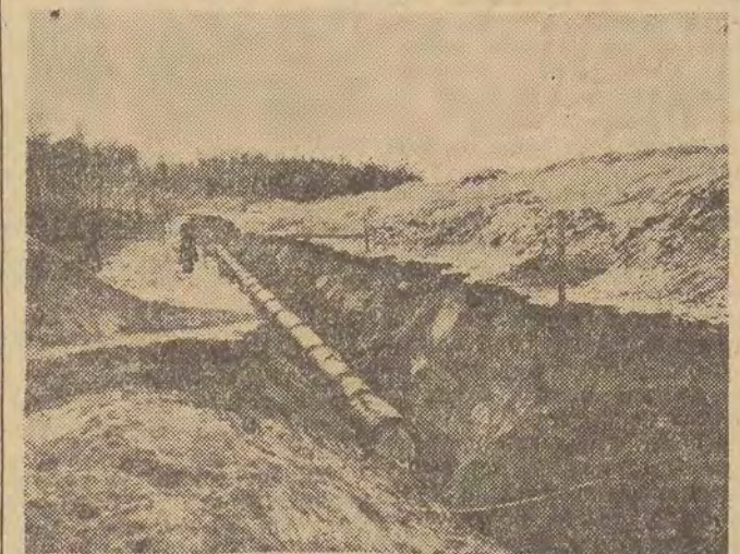
Codziennie dziesiątki metrów czarnych rur układają robotnicy w głębokim wykopie trasy rurociągu.
