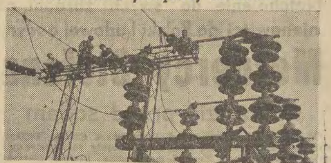
W ramach realizacji Planu 6-letniego powstaje jedna z największych w Polsce — Elektrownia Jaworzno II. Elektrownia budowana jest na podstawie dostarczonej nam przez Związek Radziecki dokumentacji technicznej i przy pomocy ekspertów radzieckich. Na zdjęciu: członkowie brygady młodzieżowej Ignacego Juchy przy montażu rozdzielni elektrowni. CAF — fot. Tyński
