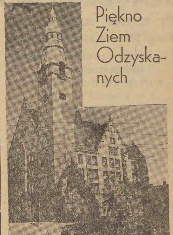
Zniszczony w czasie działań wojennych Szczecin odbudowuje się z każdym dniem. Budowniczo tego starego i bogatego tradycjach miasta portowego ze szczególną pieczołowitością odbudowują wszystkie zabudowy architektoniczne. Na zdjęciu: gmach, w którym mieści się Akademia Lekarska.
