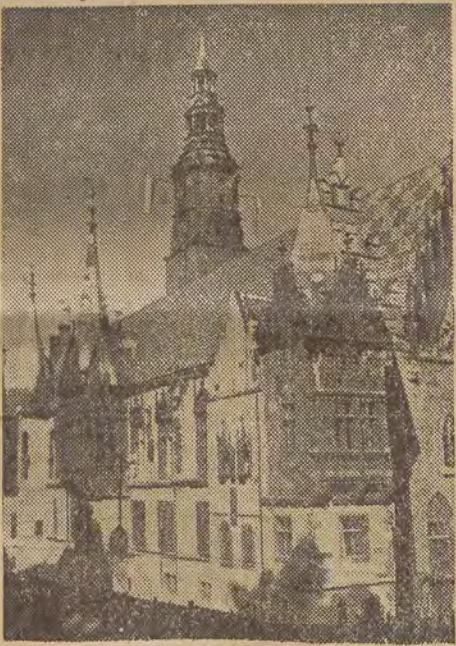
Fragment ratusza we Wrocławiu, jednego z najpiękniejszych zabytków architektonicznych naszych Ziemi Odzyskanych. CAF
