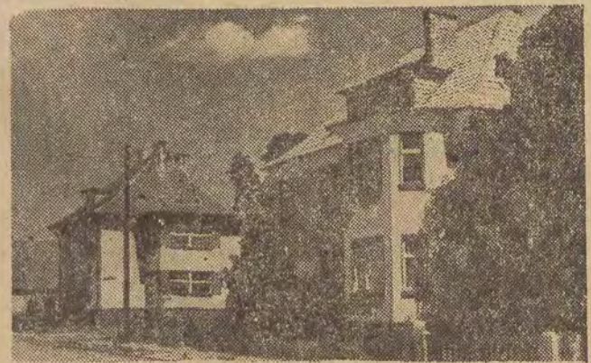
Jedna z pierwszych prac na Ziemiach Odzyskanych była odbudowa zniszczonych osiedli mieszkaniowych. W okresie od 1949 r. do 1951 r. oddano w Szczecinie do użytku ponad 6.000 mieszkań. Na zdjęciu: fragment odbudowanego osiedla w Dąbku Szczecińskim, zamieszkałego przez robotników portowych i kolejowych. CAF
