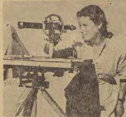
Przy budowie wielkiego kanału
