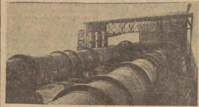
Cementownia „Wierzbica” — fragment pleców obrotowych. CAF — fot. Baranowski
