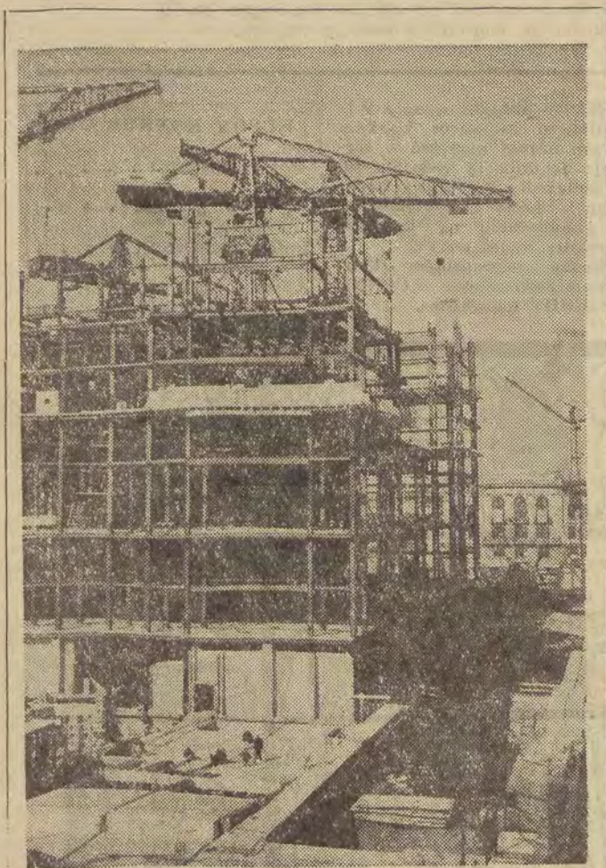
Ogólny widok stalowej konstrukcji części wysokościowej Pałacu. CAF — fot. Baranowski
