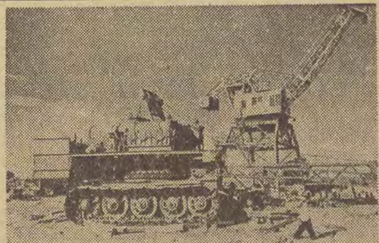
Na zdjęciu: na budowie Głównego Kanału Turkmeńskiego. Montaż koparki elektrycznej o pojemności 7 m sześć. na budowie hydrowęzła Tachia-Tasz. Fot — CAF
