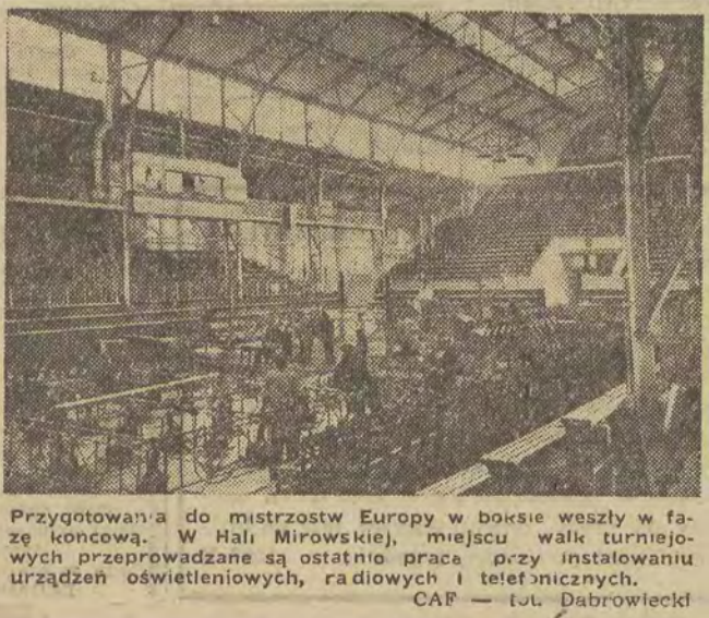
Przygotowania do mistrzostw Europy w boksie weszły w fazę końcową. W Hali Mirowskiej, miejscu walk turniejowych przeprowadzane są ostatnie prace przy instalowaniu urządzeń oświetleniowych, radiowych i telefonicznych.
