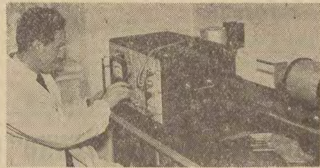
Na zdjęciu — mgr Janiszewski przy przeliczniku elektronowym — przyrządzie, przy pomocy którego studenci mierzą aktywność izotopów promieniotwórczych i absorbują promieniowania. Izotop znajduje się w walec ołowianym, którego ściany mają grubość 8 cm. Otwór, przez który izotop promieniuje, zakrywa się różną ilością ołowianych płytek, a aparat rejestruje natężenie promieniowania.
