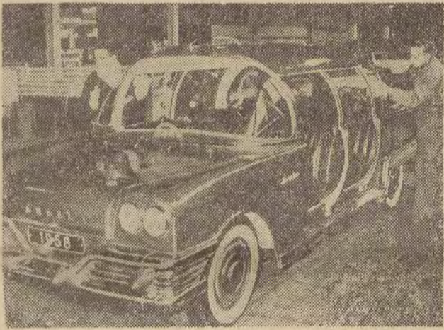
Jedną z atrakcji genewskiego salonu samochodowego jest 6-osobowy samochód produkcji francuskiej „Arbel”, posiadający karoserię z plastyku, o rozsuwanych drzwiach i oknach. Do napędu tego samochodu można używać benzyny, gazu lub... paliwa atomowego.
