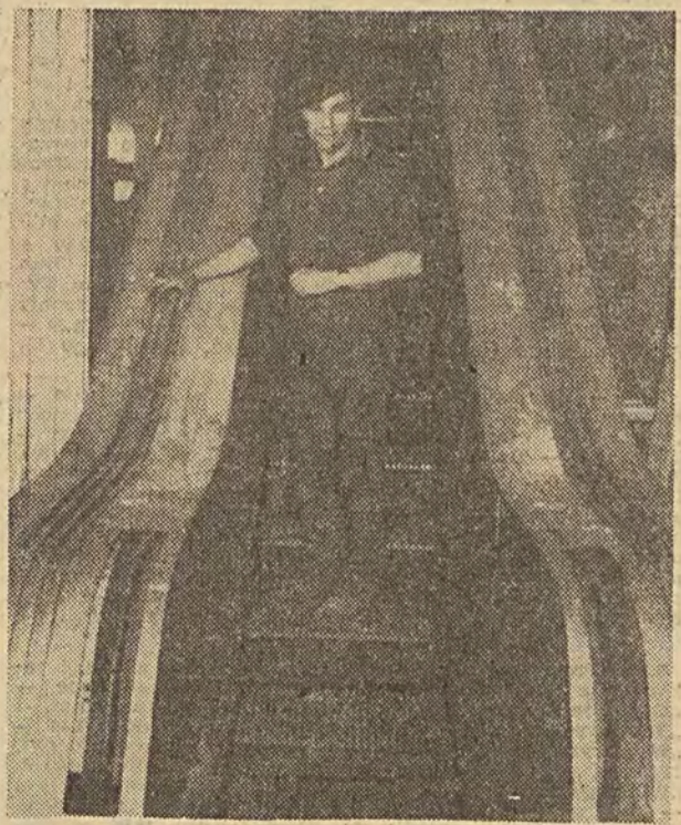
W PDT na Placu Niepodległości ukończono obudowę aluminiową gotowych już ruchomych schodów, tzw. trzeciego biegu. Jak nas informuje kierownik budowy inż. Zbigniew Stachowicz, są trzy kondygnacje schodów tworzące 6 biegów. Koszt konstrukcji mechanicznej sięga około 4 mln. złotych.
