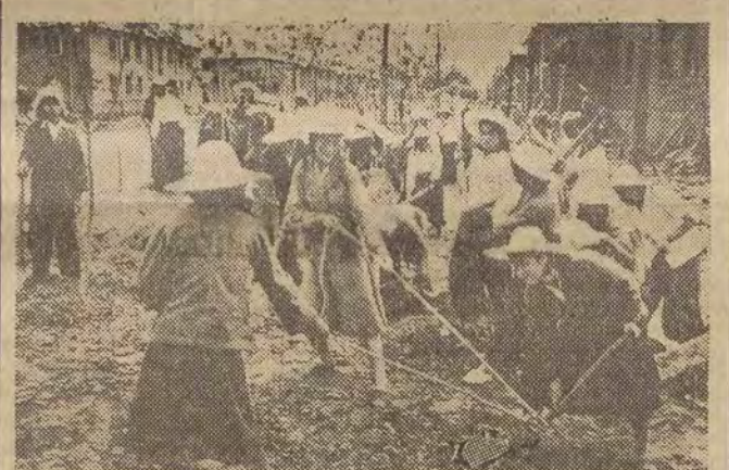
Uczennice szkół średnich przy budowie chodnika na ulicy Bologwe w Phenianie.
