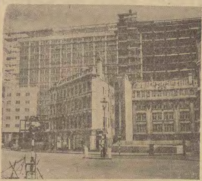
London. Gmach przeznaczony na cele handlowe w pobliżu giełdy i banku angielskiego powstaje na miejscu ruin wojennych. Fot. — CAF
