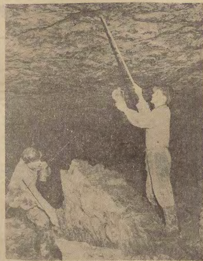
W tej komorze skały imitująco są podobne do lodowca. Dla pewności sprawdzamy kijkiem czy nie grozi nam niebezpieczeństwo. Zdarzały się bowiem wypadki, że zawalały się całe sufity. (Do reportażu obok).
