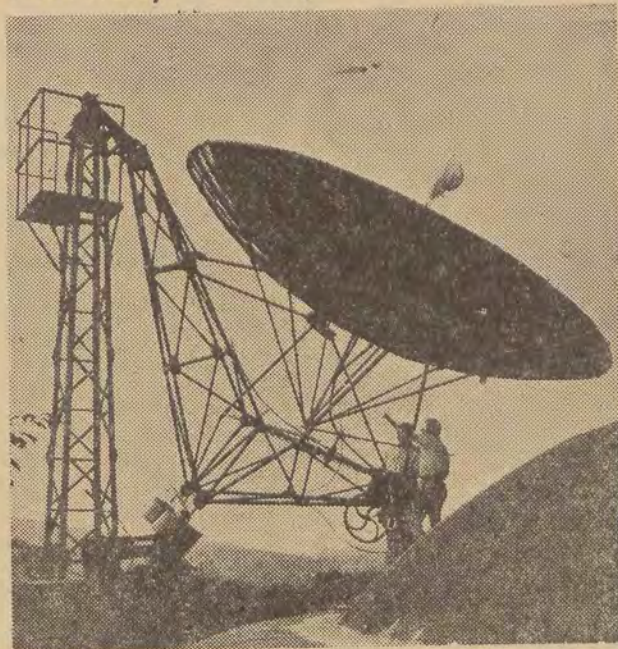
Na zamiejskiej stacji krakowskiego Obserwatorium Astronomicznego uruchomiono niedawno pierwszy w kraju radioteleskop, umożliwiający badanie radiopromieniowania ciał niebieskich a szczególnie słońca. Na zdjęciu: nowouruchomiony radioteleskop. CAF — fot. Link.
