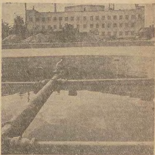
W Świerku pod Warszawą w Centralnym Ośrodku Badań Jądrowych trwa montaż pierwszego polskiego reaktora doświadczalnego. Po zmontowaniu urządzeń odbędzie się obecnie betonowanie. Uruchomienie reaktora przewidziane jest na początek przyszłego roku.
