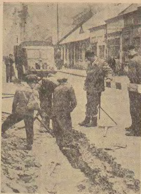
Ulica Nawrot. Fragment budowy gazociągu, który połączy gazownię ze zbiornikiem na Karolewie.
