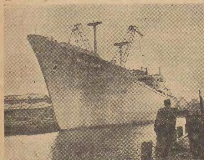
W basenie wyposażeniowym Stoczni Gdańskiej trwają prace na szóstym kolejnym dziesięciotysięczniku „General Sikorski”. CAF — fot. Uklejewski
