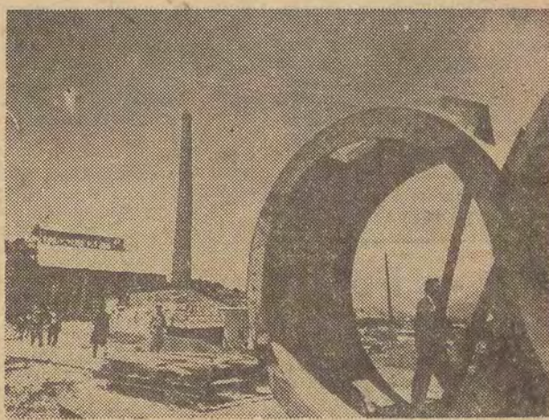
Na budowie huty szklanej w Tiranie. Fot. — CAF
