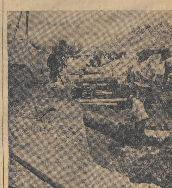
Każdy dzień przynosi nowy obraz sytuacji w budowie rurociągu Pilica—Łódź. Przybywa coraz więcej metrów ułożonych rur — coraz bliższy jest termin uruchomienia olbrzymiego rurociągu. Na zdjęciu: prądująca brygada montażowa M. Szczepińska układa rury w wykopie.
