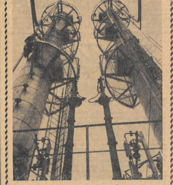
W zakładach w Blachowni Śląskiej. CAF - Okońska
