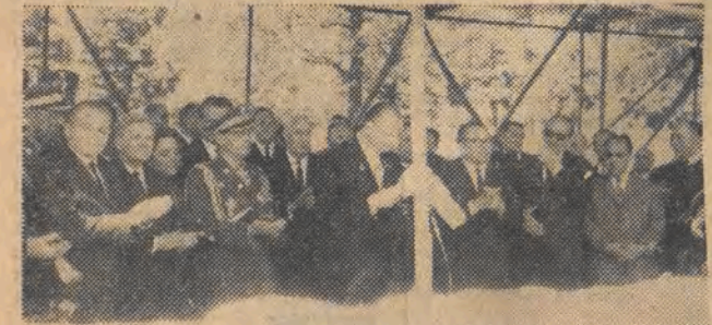
Zaproszeni goście na uroczystości wmurowania aktu erekcyjnego pod pawilon dla Wydziału Budownictwa Lądowego Politechniki Łódzkiej. Foto - L. Olejniczak
