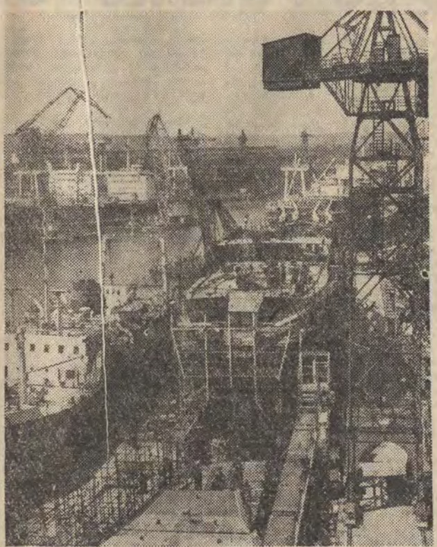
Na zdjęciu: Stocznia Gdańska im. Lenina. Montaż drewnowca B45/66 dla armatora radzieckiego i trawiera przetwórci B-26.
