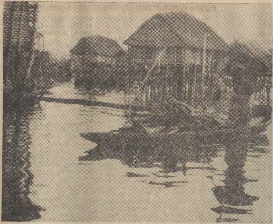
Chaty Adża są „zbudowane” z bambusów i osadzone na wystających ponad tafel laguny pniach drzewa tekowego.
