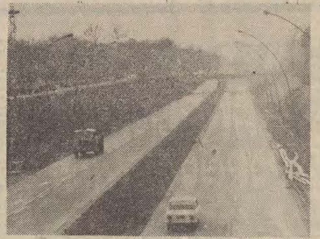
Między Katowicami a Krakowem budowana jest droga szybkiego ruchu o 2 jezdniach i 2 pasmach ruchu na każdej. N/z: zrealizowany już odcinek drogi w rejonie Katowic. CAF - Jakubowski
