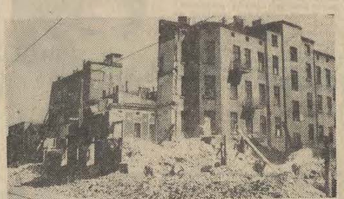
Całkowicie bez poślachu tak, aby nie uszkodzić cennyh materiałów budowlanych - trwała rozbiórka domów przy ul. Zachodniej. Na sześćście kończy się już roboty rozbiórkowe przy ostatnim budynku. W końcu sierpnia zostanie ostatni dom na tej tak ważnej arterii komunikacyjnej.
