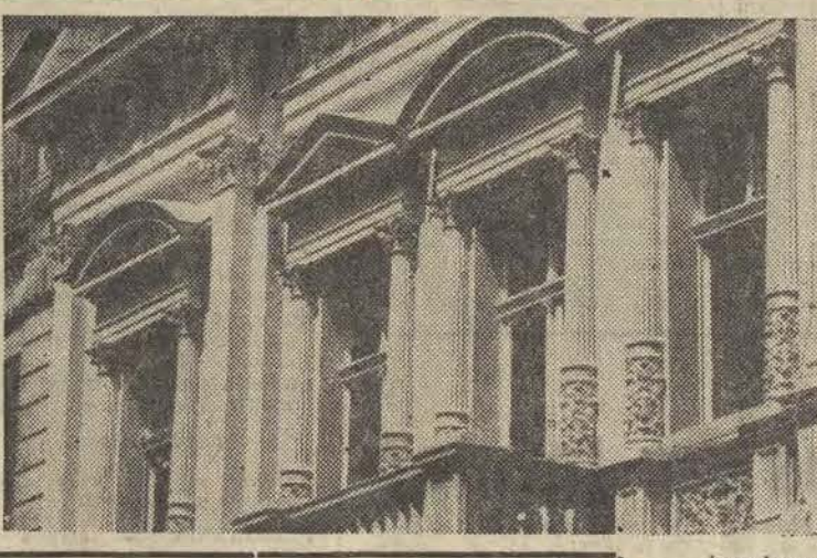
81 elewacji przy ul. Piotrkowskiej zamiast planowanych 68.
