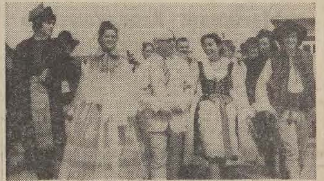
Henryk Jabłoński w dniu 4.07.1973 na terenie budowy hydroelektrowni szczytowo-pompowej Porąbka-Zar, serdecznie witany przez przedstawicieli społeczeństwa powiatu żywieckiego. CAF Sochor - telefoto
